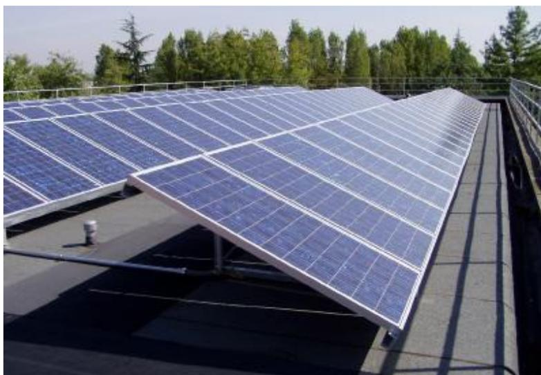
Figura 1 – Esempi di sistemi fotovoltaici a moduli su supporto inclinato
