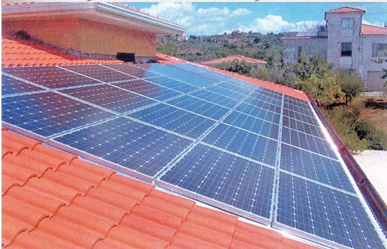
Figura 2 – Esempi di sistemi fotovoltaici a moduli ancorati al sistema di copertura
